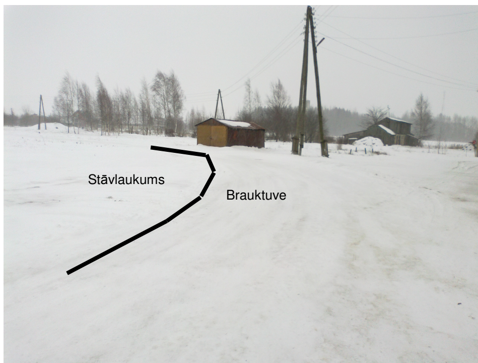
Attēls (pk 1+20) – ielas brauktuve apvienota ar stāvlaukumu, kas no satiksmes drošības viedokļa ir ļoti bīstams risinājums.
